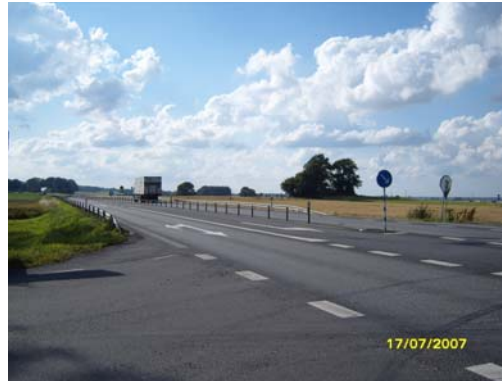
Figur 4.20 Öppningar i mitträcket är 6 meter breda för traktorer (Foto: Zainab Mousa)
