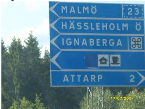
Figur 4.19 Vägmärken är av strängpressad aluminium och högrelekterande
