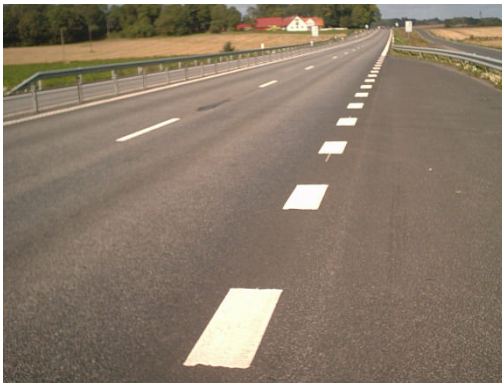
Figur 4.3 Väg 21 efter ombyggnaden, (Foto: Zainab Mousa)
