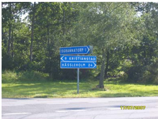
Figur 4.29 Vägmärken är strängpressad aluminium och är högre reflekterande (Foto: Zainab Mousa)
